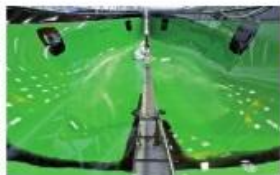
Preparación de molde y molde girado para facilitar la laminación. La tercera imagen muestra una cubierta en infusión al vacío.
