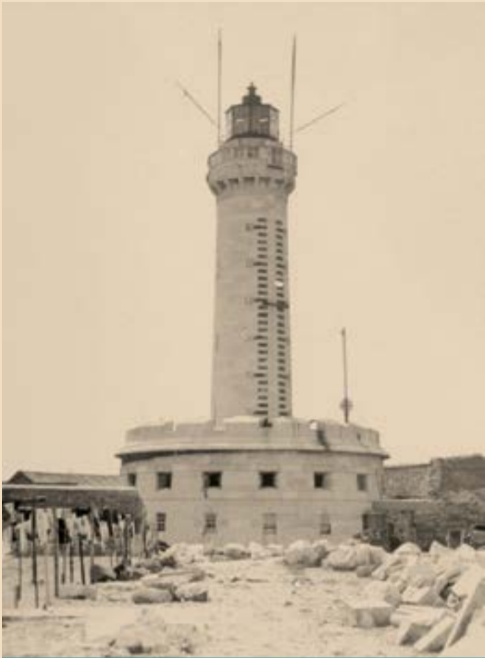
Il Faro detto della Lanterna, con la curiosa scala barometrica a tacche
